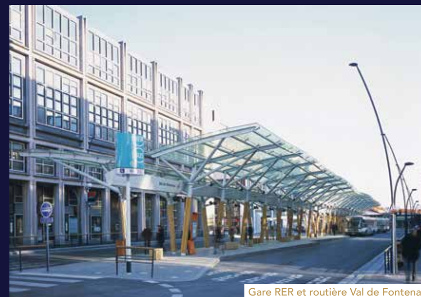
Gare RER et routière Val de Fontenay
